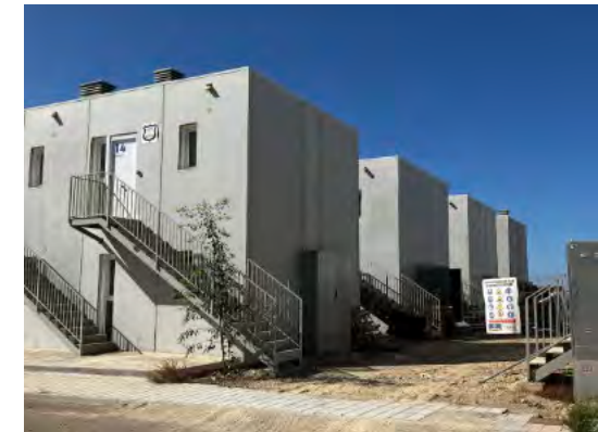
Alojamientos dotacionales municipales construidos recientemente en Los Grillos.
